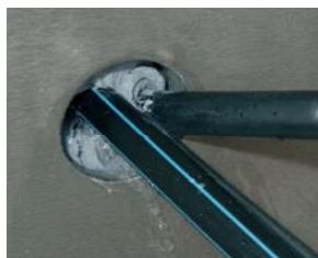
Füllen des Ringspaltes
