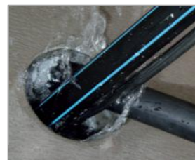
Einspritzen von Flex 2000
