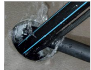
Einspritzen von Flex 2000
