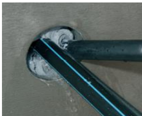
Füllen des Ringspalt
